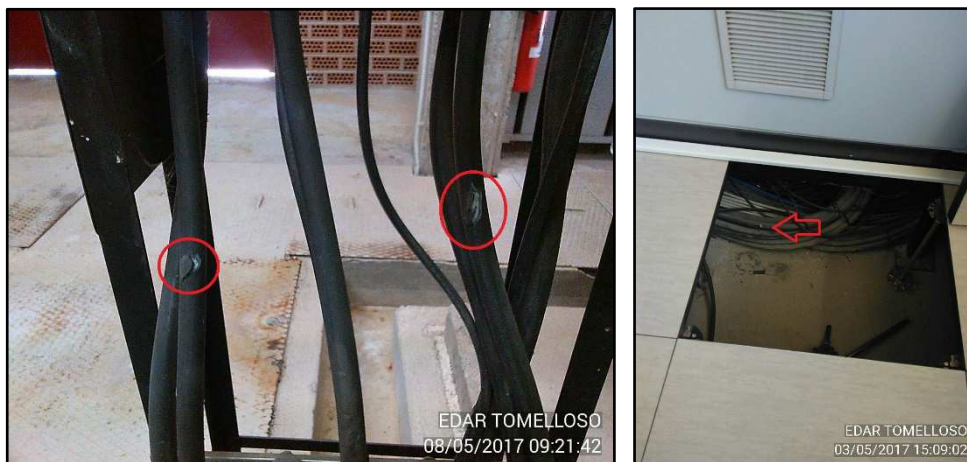
Muecas realizadas en distintos cables en Mayo de 2017. Izquierda: Motor de cogeneración. Derecha: CCM4
